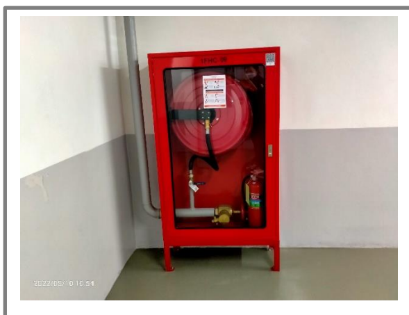
รูปที่ 3.1-46 ตู้เก็บสายฉีดน้ำดับเพลิง
