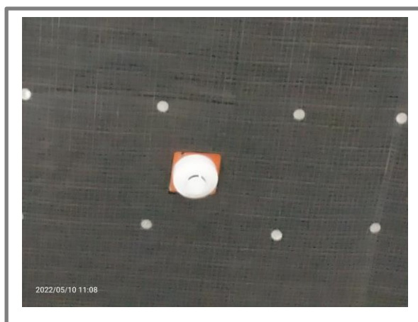
รูปที่ 3.1-40 เครื่องตรวจจับควันภายในห้องเครื่องไฟฟ้า
