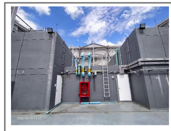
รูปที่ 3.1-17 ถังสำรองน้ำชั้นดาดฟ้าของทาวเวอร์ B
