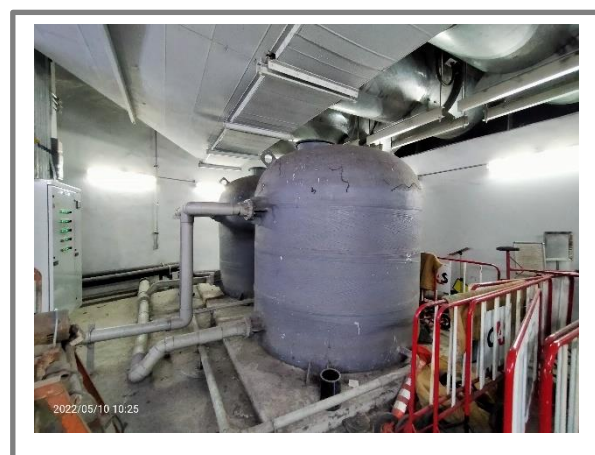
รูปที่ 3.1-13 ถังบำบัดก๊าซมีเทน
