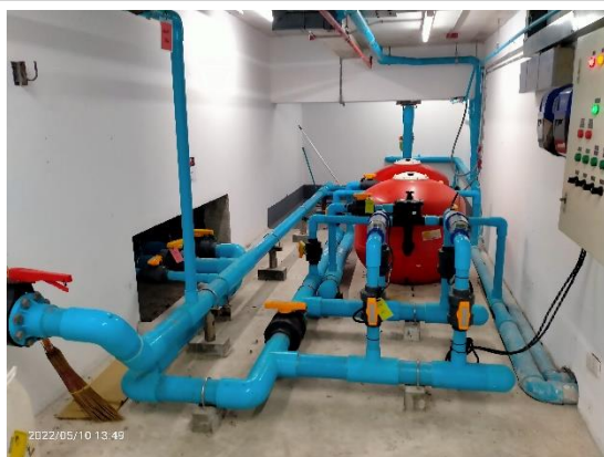
รูปที่ 3.1-22 ระบบกรองของสระว่ายน้ำ
