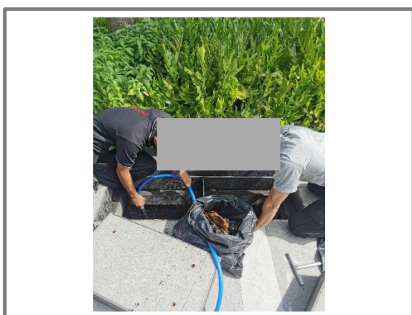
รูปที่ 3.1-73 ทำความสะอาดท่อน้ำทิ้ง ขุดลอกตะกอน
