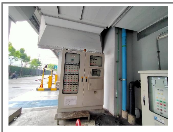
รูปที่ 3.1-14 ระบบมิเตอร์ไฟฟ้าสำหรับบำบัดน้ำเสีย
