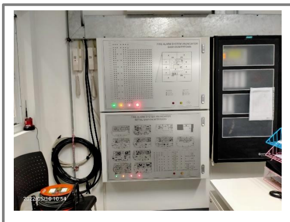
รูปที่ 3.1-50 แผงควบคุมระบบอัคคีภัย
